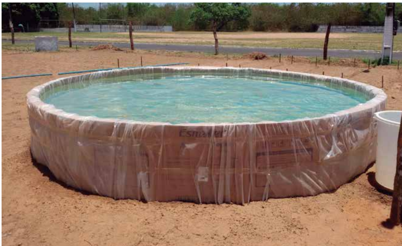
Tanque pronto revestido com papelão e plástico.
