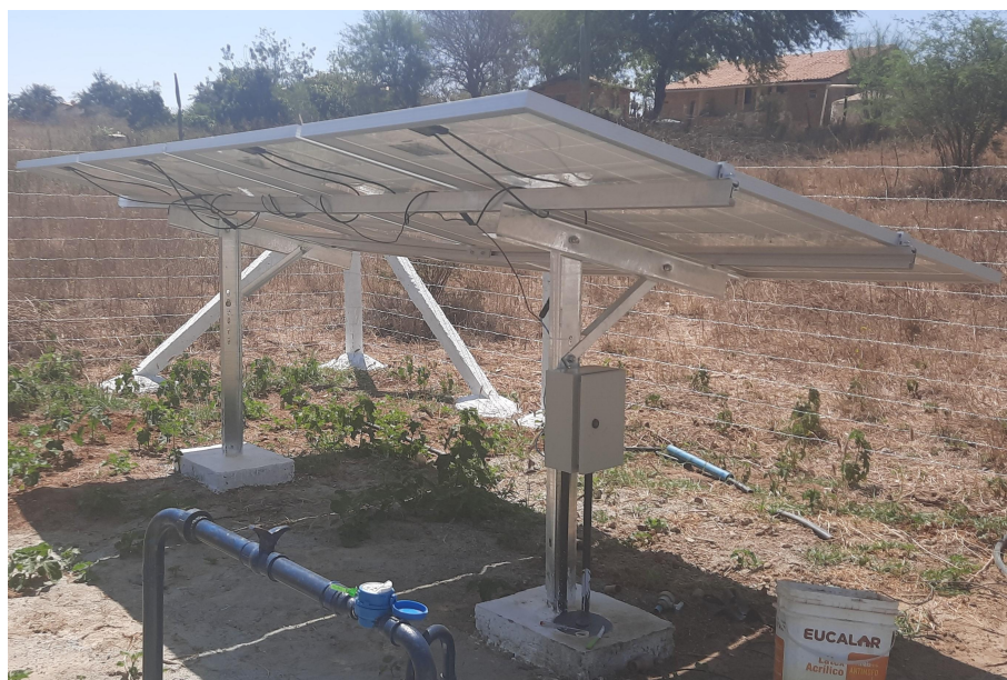
Foto 01 – Fixação de caixa metálica diretamente no pilar
