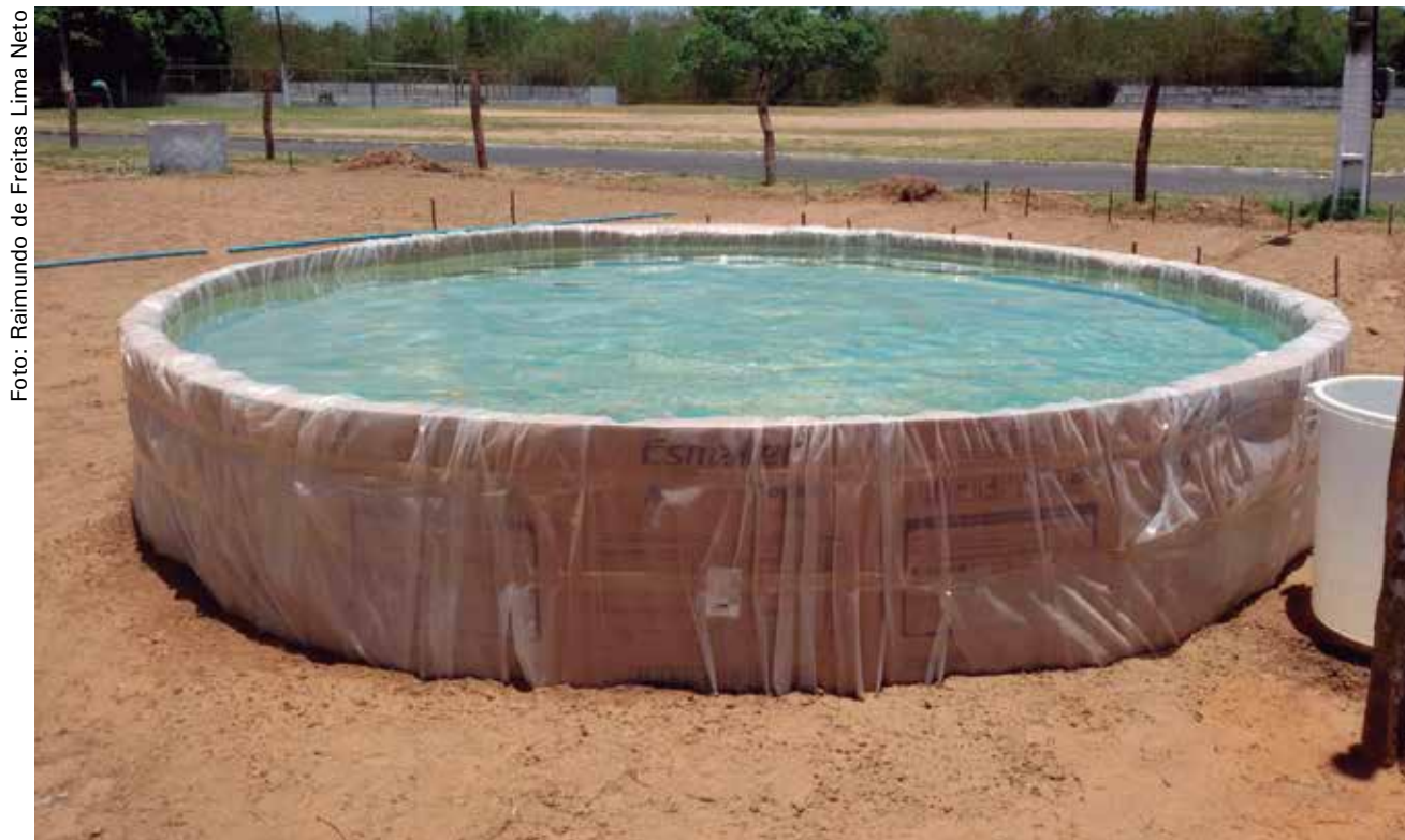
Tanque pronto revestido com papelão e plástico.
