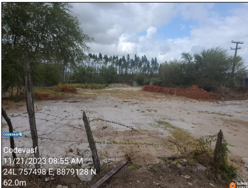
Figura 9 - Entrada do terreno de Igreja Nova em que será construída a Casa de Leite.
