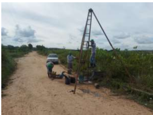
Foto 09 EXECUÇÃO DE SONDAGEM À PERCUSSÃO (SPT).
