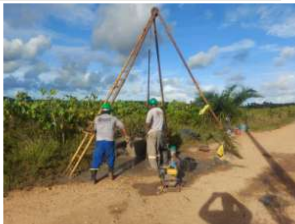
Foto 14 EXECUÇÃO DE SONDAGEM À PERCUSSÃO (SPT).
