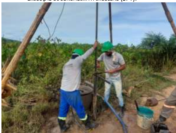
Foto 03 EXECUÇÃO DE SONDAGEM À PERCUSSÃO (SPT).
