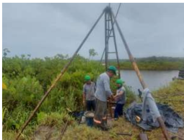
Foto 18 EXECUÇÃO DE SONDAGEM À PERCUSSÃO (SPT).
