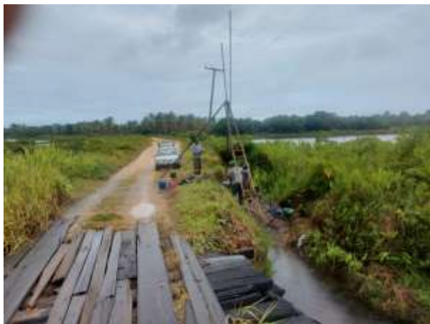
Foto 01 EXECUÇÃO DE SONDAGEM À PERCUSSÃO (SPT).
