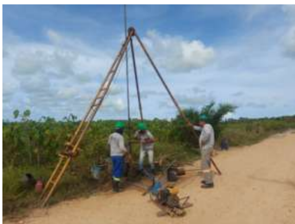
Foto 11 EXECUÇÃO DE SONDAGEM À PERCUSSÃO (SPT).
