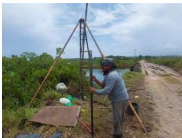
Foto 16 EXECUÇÃO DE SONDAGEM À PERCUSSÃO (SPT).
