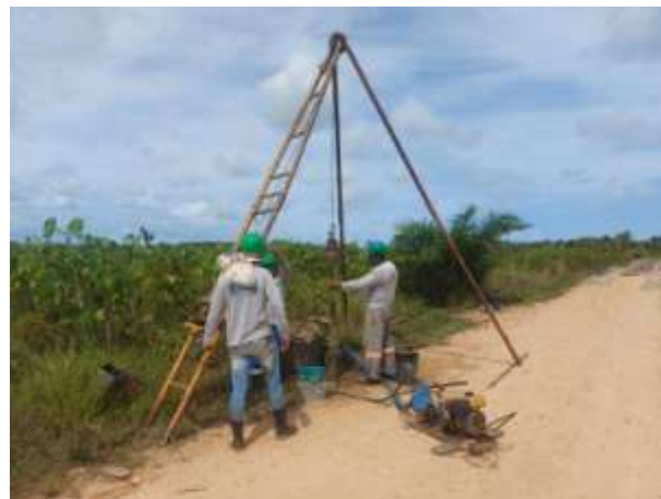
Foto 02 EXECUÇÃO DE SONDAGEM À PERCUSSÃO (SPT).
