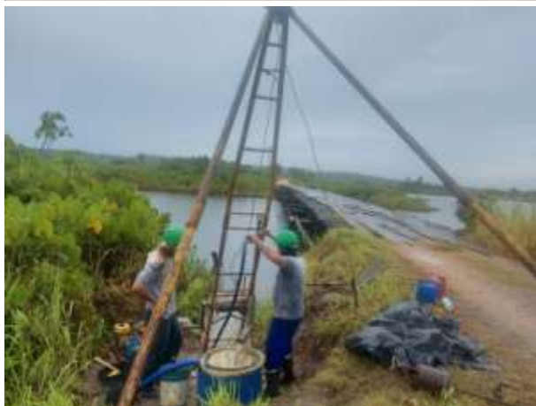
Foto 13 EXECUÇÃO DE SONDAGEM À PERCUSSÃO (SPT).
