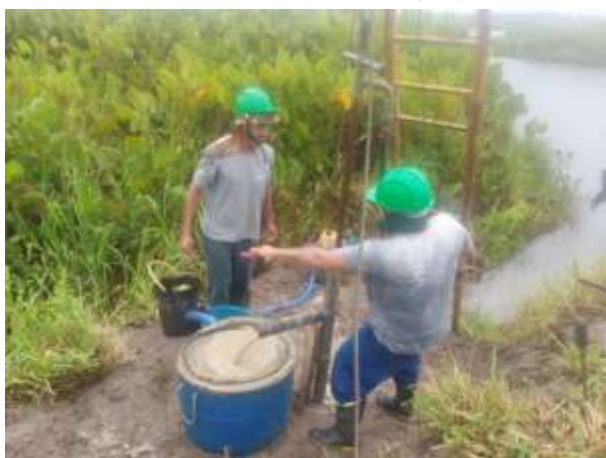
Foto 05 EXECUÇÃO DE SONDAGEM À PERCUSSÃO (SPT).
