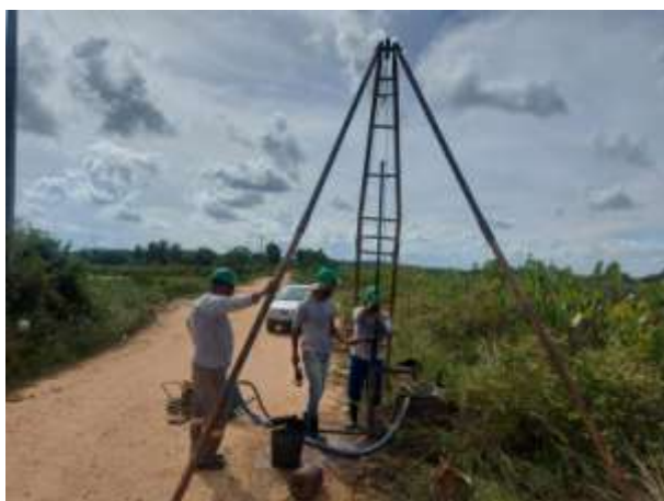
Foto 15 EXECUÇÃO DE SONDAGEM À PERCUSSÃO (SPT).
