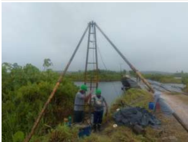
Foto 07 EXECUÇÃO DE SONDAGEM À PERCUSSÃO (SPT).
