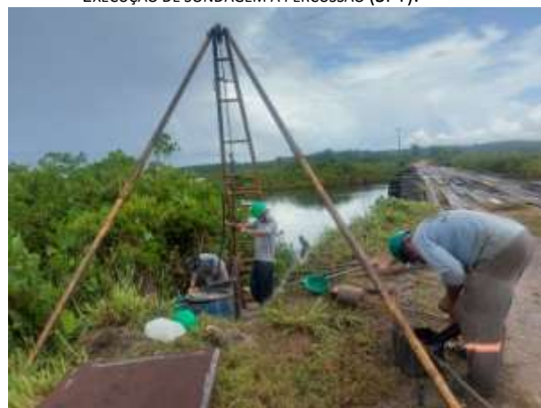
Foto 04 EXECUÇÃO DE SONDAGEM À PERCUSSÃO (SPT).
