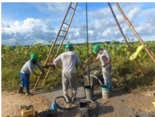
Foto 17 EXECUÇÃO DE SONDAGEM À PERCUSSÃO (SPT).
