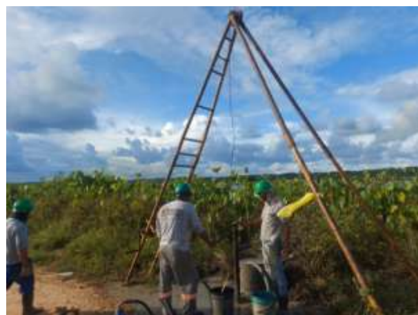
Foto 10 EXECUÇÃO DE SONDAGEM À PERCUSSÃO (SPT).
