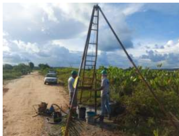
Foto 12 EXECUÇÃO DE SONDAGEM À PERCUSSÃO (SPT).
