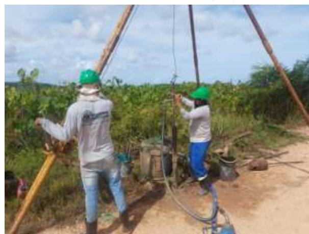
Foto 06 EXECUÇÃO DE SONDAGEM À PERCUSSÃO (SPT).
