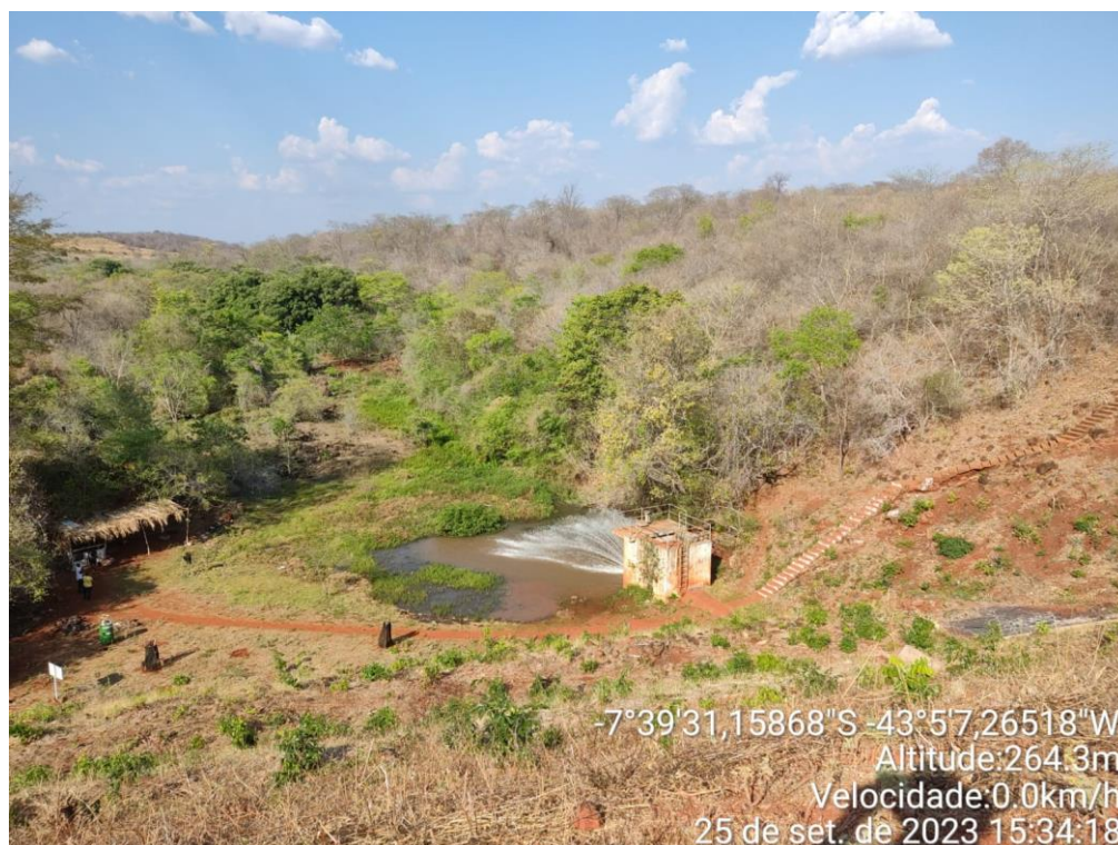
Figura 3 – Dissipador de energia da barragem
