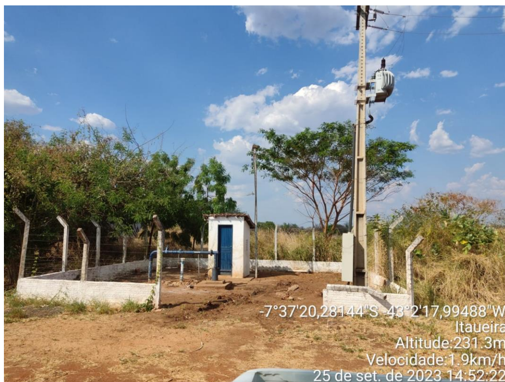
Figura 9 – Captação por Poço Artesiano no Município de Itaueira
