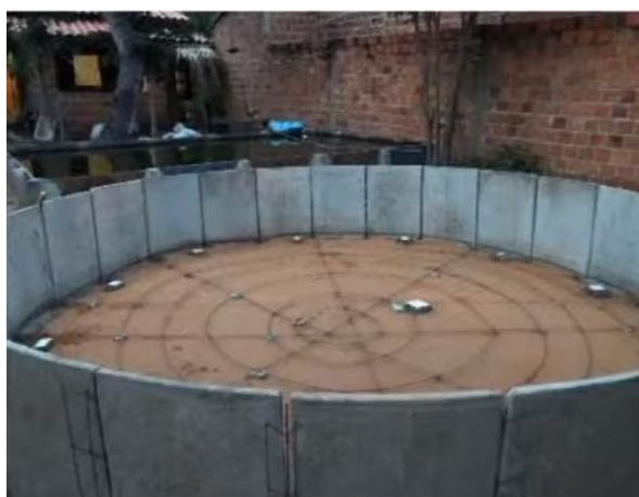
Figura 2: Demonstração da disposição das 24 placas.
