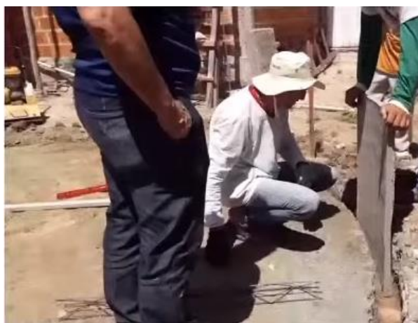
Figura 8: Demonstração da fixação das placas de concreto.
