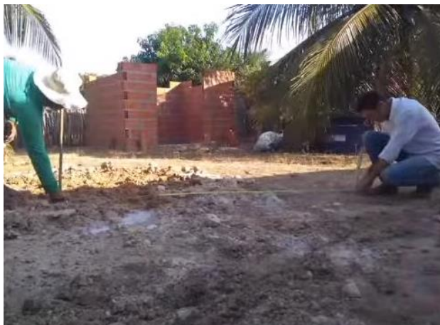
Figura 1: Demonstração da marcação do perímetro do reservatório.
