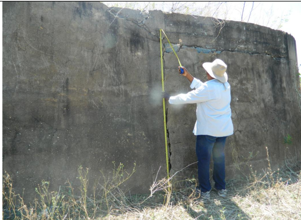
Trinca vertical na estrutura do vertedouro
