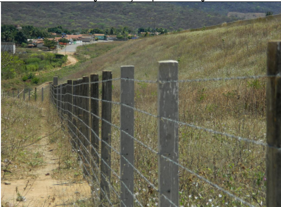
Talude à jusante: instalação de cerca; necessário serviços de manutenção e limpeza
