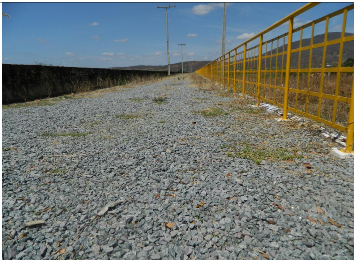
Coroamento: revestimento com brita e instalação de guarda-corpo no lado de jusante
