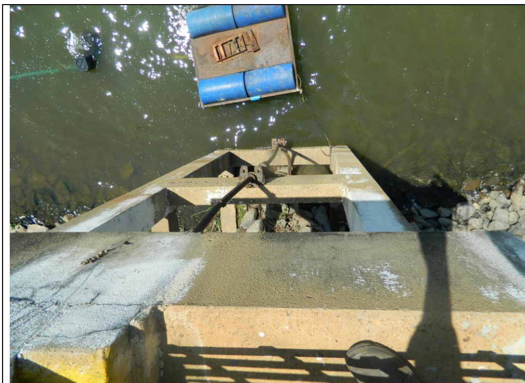
Tomada d'água: Presença de trincas e rachaduras ao longo da estrutura de concreto
