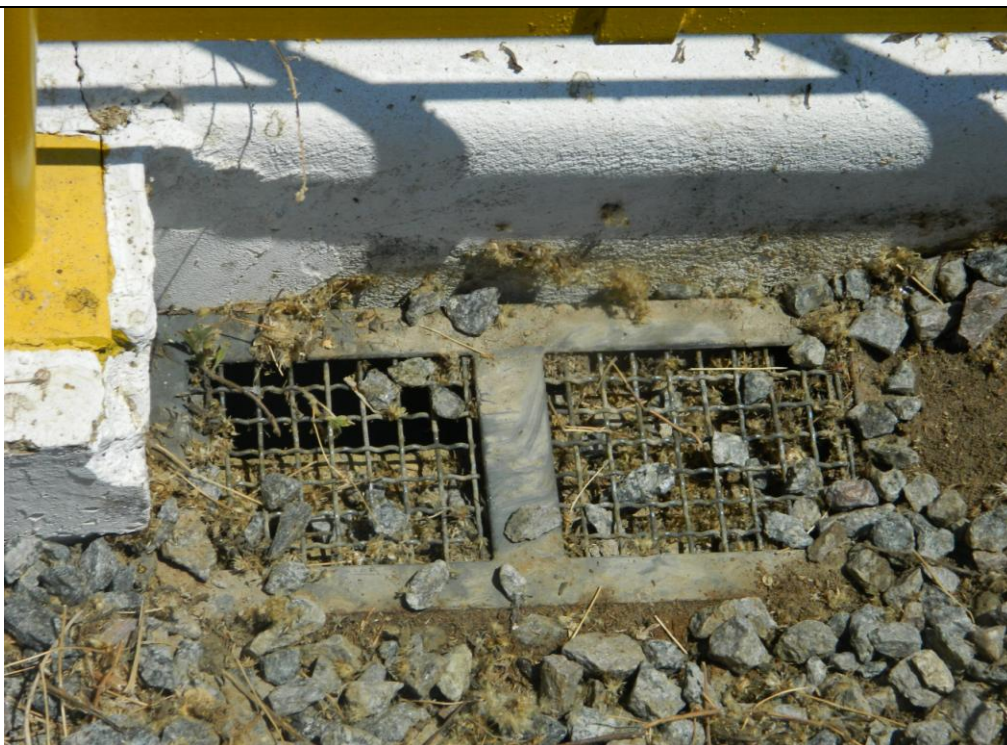
Coroamento: foram instaladas grelhas de aço nos pontos de drenagem
