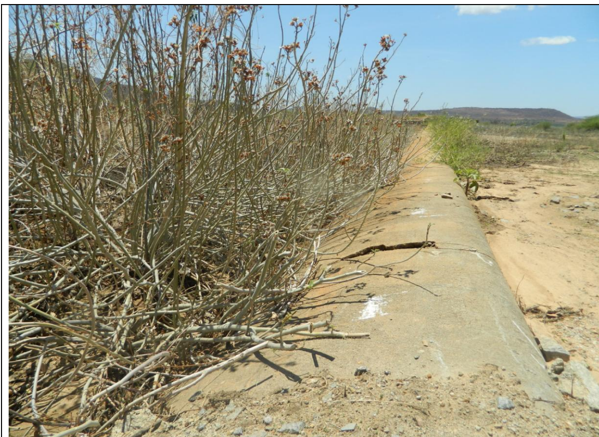
Vertedouro: erosões na estrutura e vegetação arborea
