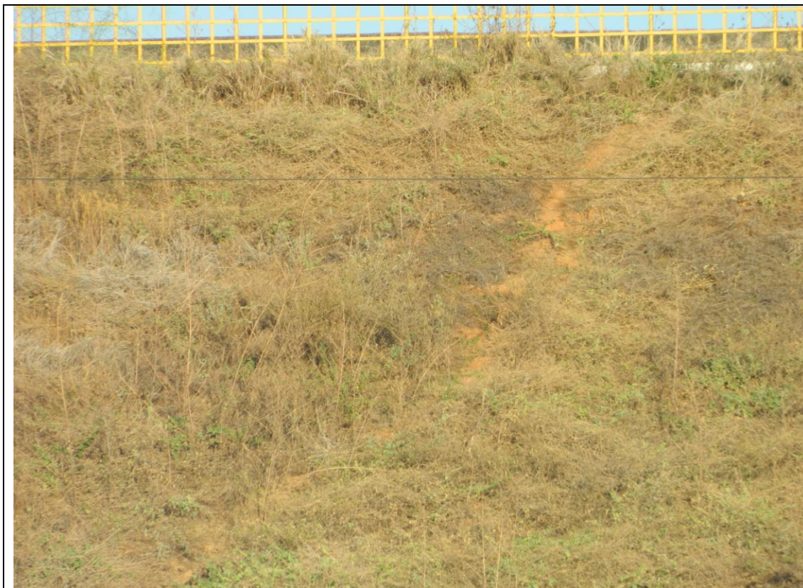
Talude de jusante: erosões superficiais
