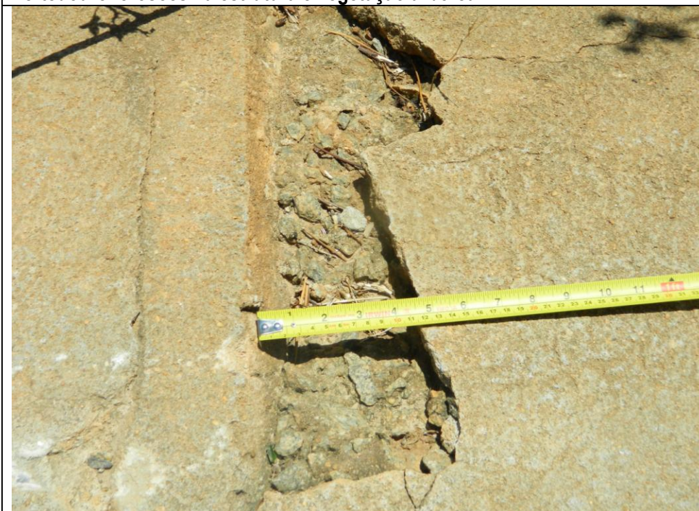
Soleira do vertedouro com erosões
