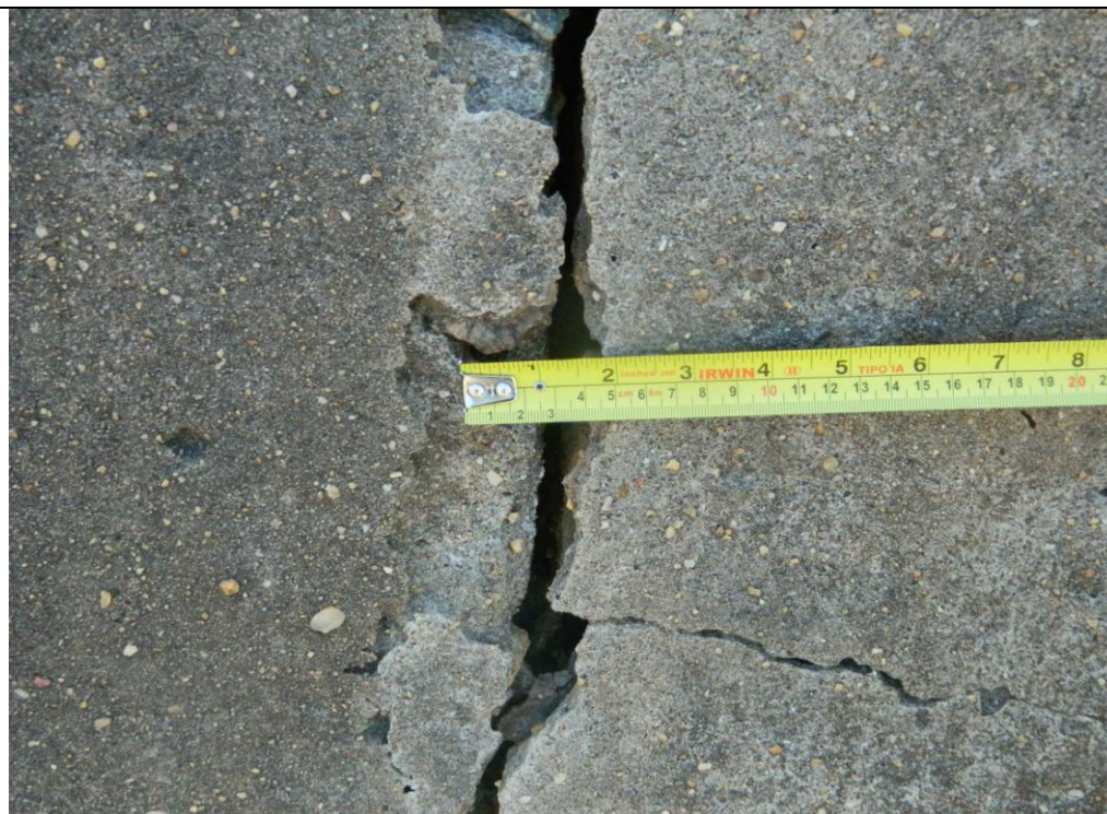
Trincas na soleira do vertedouro
