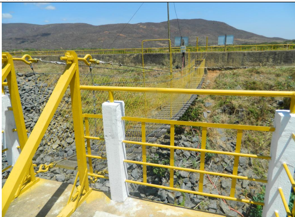
Passadiço da tomada d'água: foi recuperado.
