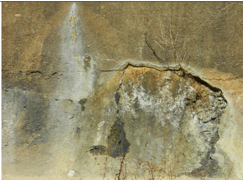
Vertedouro: erosões no concreto
