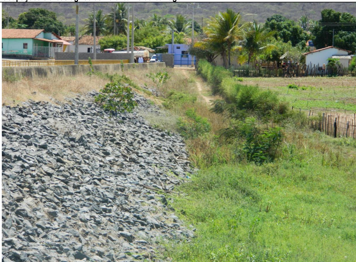
Area de montante: presença de vegetação rasteira, sendo necessário serviços de manutenção
