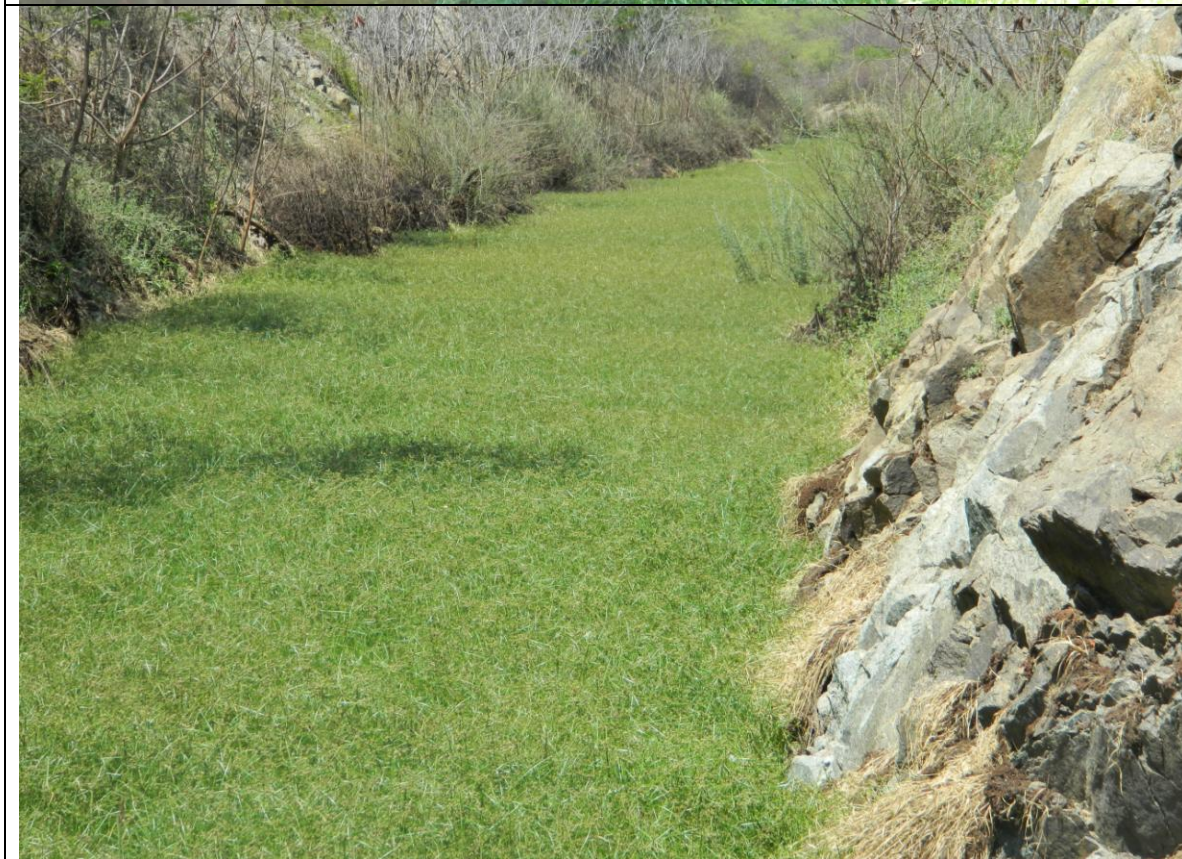
Canal do tronco adutor com presença de vegetação
