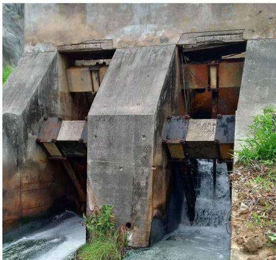
**Figura 3 – Comportas segmento da descarga de fundo.**
