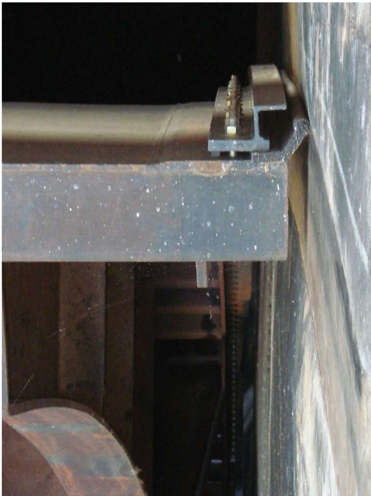
Foto Nº 4 - Detalhe da Vedação Lateral Tipo Nota Musical da Comporta.
