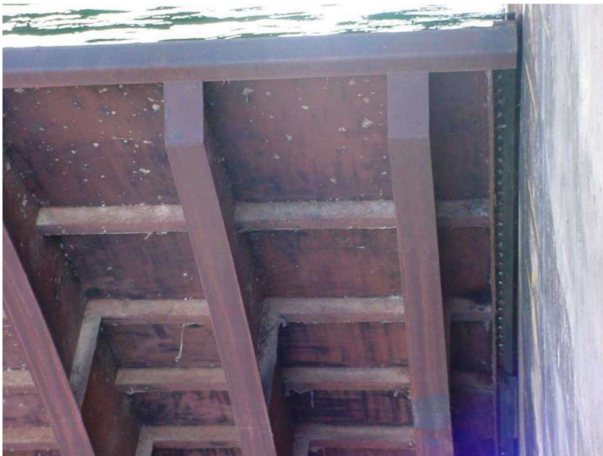
Foto Nº 0 1 - Detalhe da Vedação Lateral (Vista Lateral Superior Direita) da Comporta
