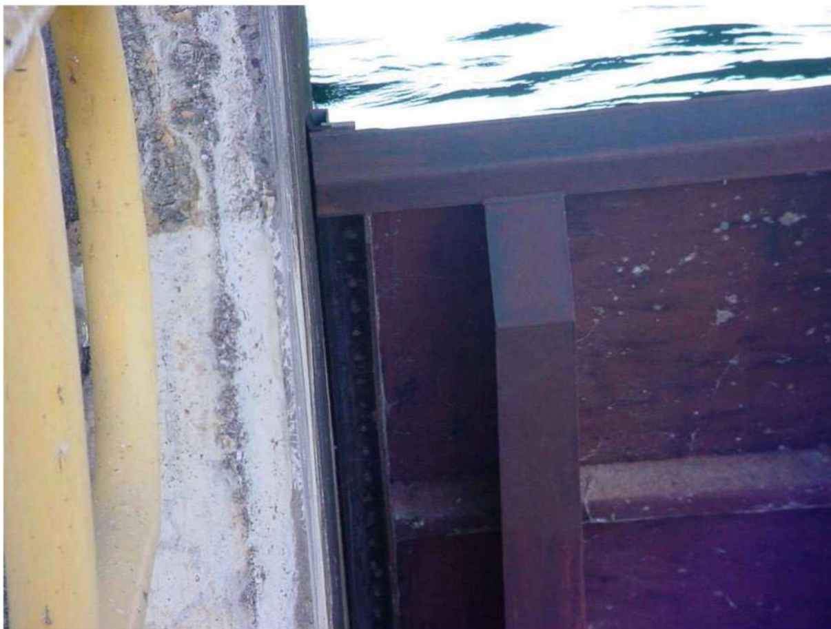
Foto Nº 3 - Detalhe da Vedação Lateral (Vista Superior Esquerda) da Comporta
