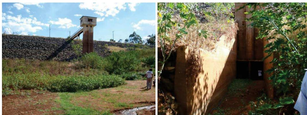
Figura 6 – Vista geral da tomada d'água e da entrada da tomada d'água com reservatório aproximadamente vazio.
