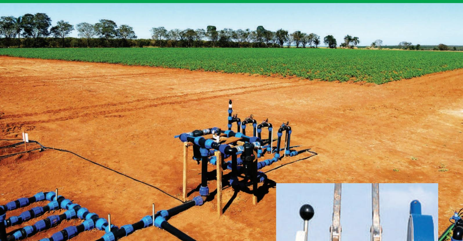
Instalação superficial de tubulação de polietileno com cavaletes de setorização e filtragem também em polietileno.
