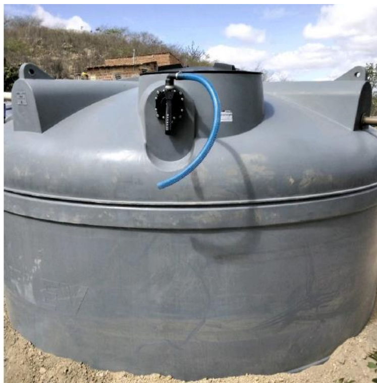
Figura 5: Exemplo de reservatório de 16.000L instalado.
