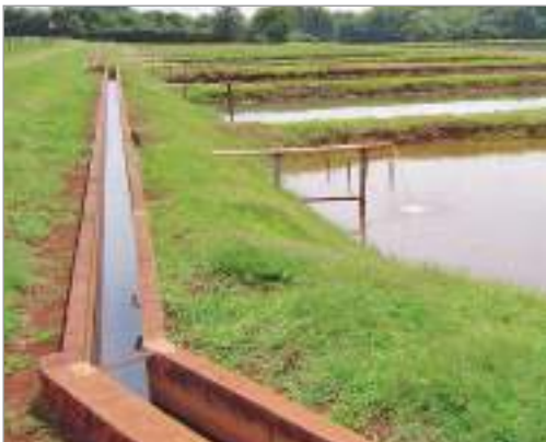
FIGURA 15 - Sistema de Abastecimento
