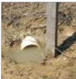
A) Tubo de 100mm aterrado e estaca de suporte do cotovelo/cachimbo
