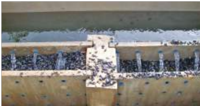
FIGURA 16 - Filtro mecânico
