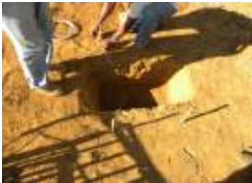
Preparação da forma escavada
