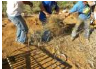
Compactação do material
