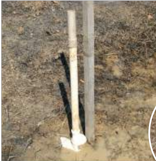
D) Tubo de esgotamento montado
