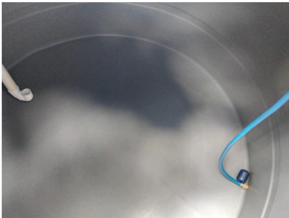
Figura 7: interior da cisterna após a instalação.
