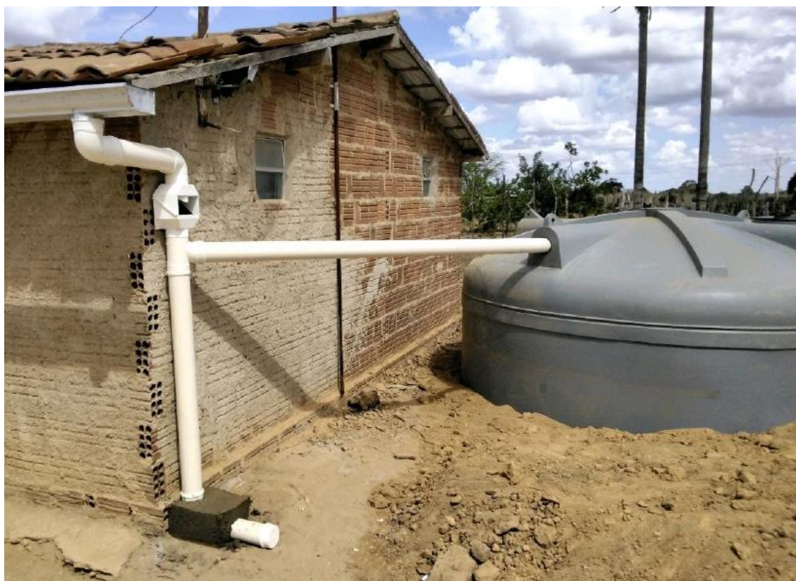
Figura 8: Visão geral da cisterna instalada.
