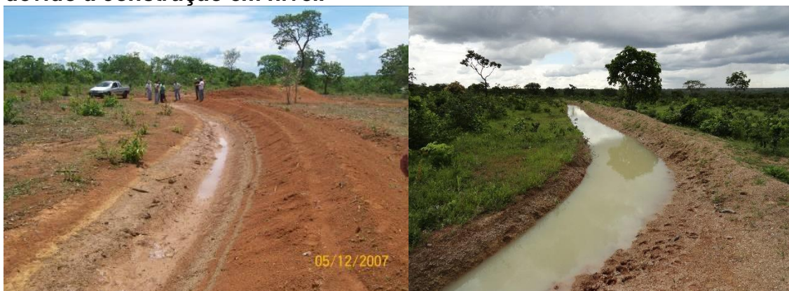
Figura 16: terraços demonstrando a função de acúmulo e infiltração de água devido à construção em nível.
