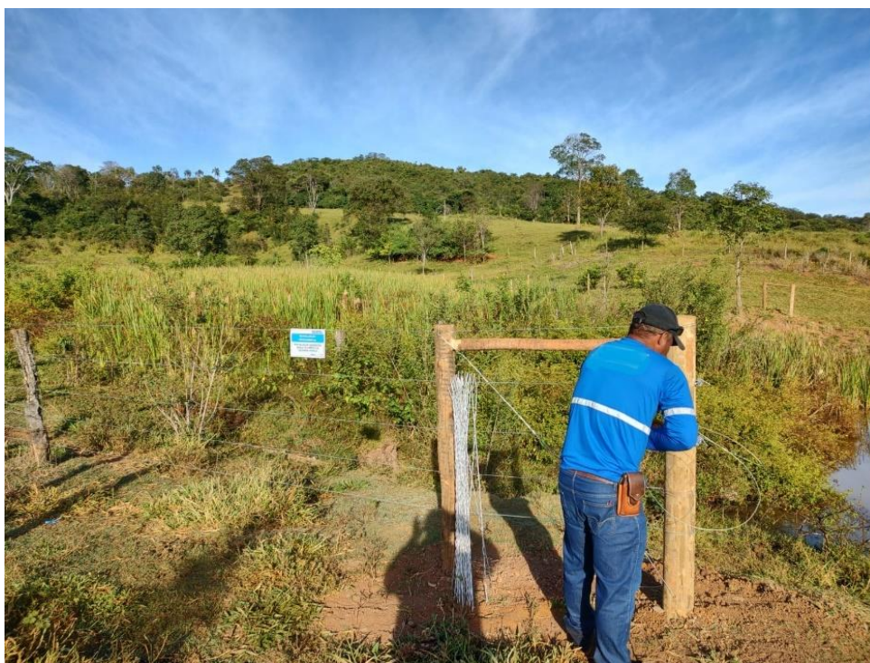
Figura 18: Exemplo de estrutura de escoramento superior. Codevasf (2023).
