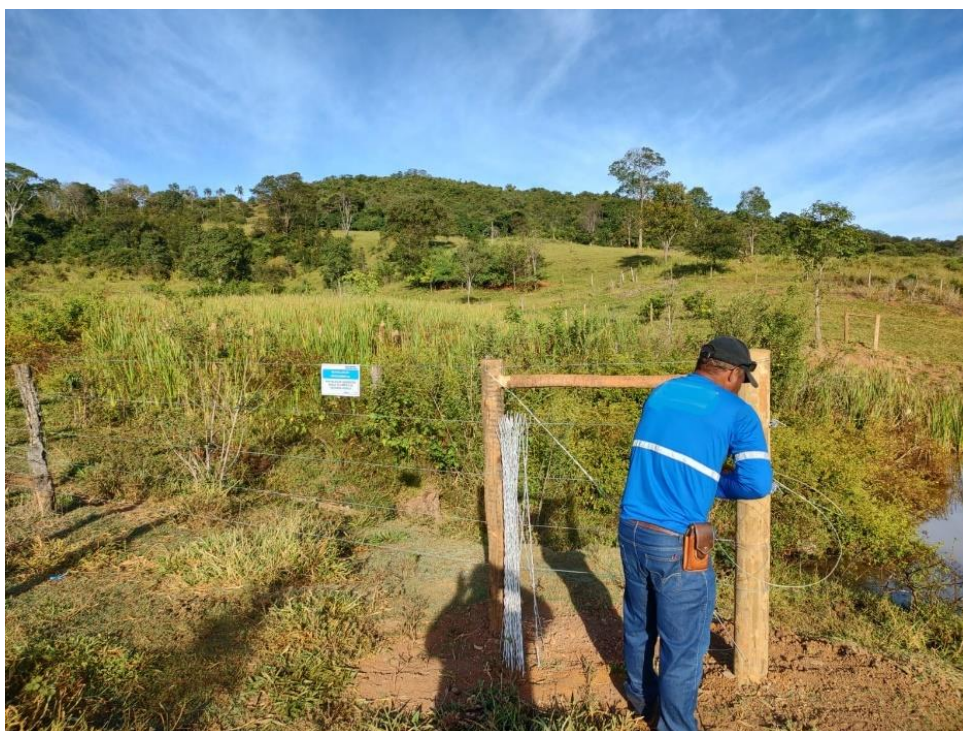
Figura 18: Exemplo de estrutura de escoramento superior. Codevasf (2023).
